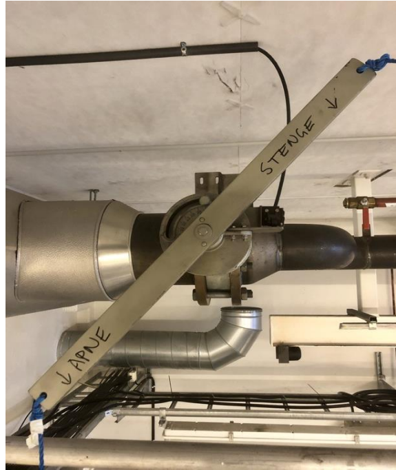
Figur 27. Endebryter eksosspjeld, posisjon åpen.
