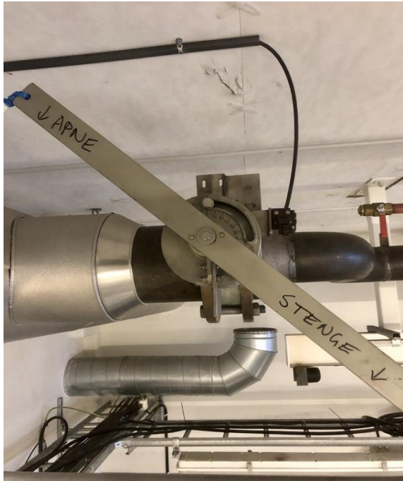
Figur 26. Endebryter eksosspjeld, posisjon lukket.
