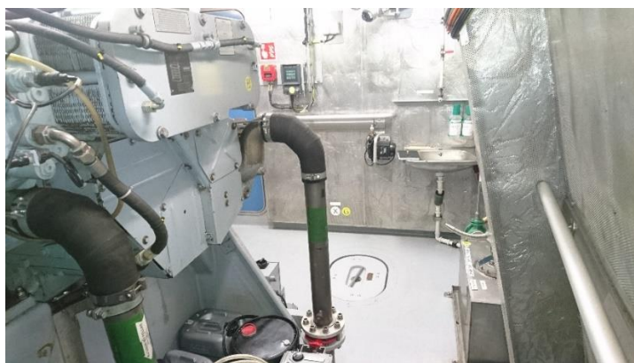
Figur 7. Bilde av tilgjengelig plass ved løftevifte
