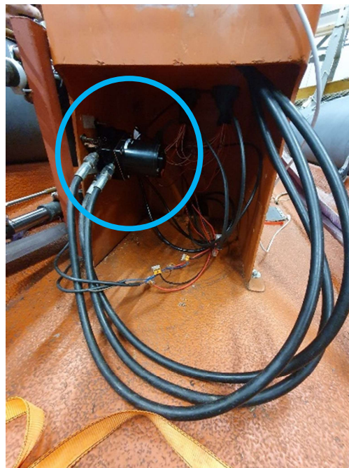
Figur 3.3: Hydraulikkpumpe montert under styringskonsollen
