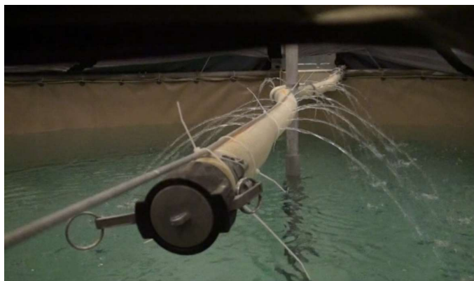
Figur 3: Lufting ved hull i vannledning. Bildet fra rensanlegg i Tsjad (Hegg, 2018)
