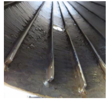
Figur 43 Kjølevannsribbene til eksisterende lyddemper - rapport lyddemper
